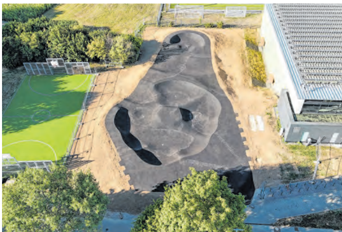
Bauphase der Rollsportanlage an der Lindach-Sporthalle.
